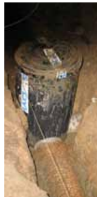
Aanleg infiltratieleiding in kruipruimte Heysterbachstraat te Dordrecht
