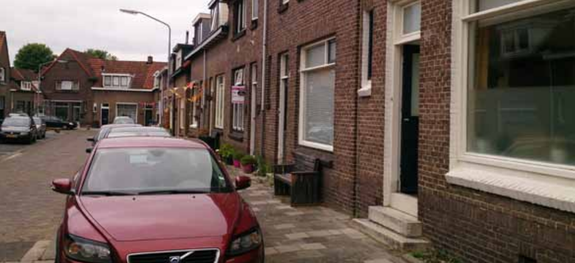
Almsvoetstraat. Infiltratieleiding loopt onder parkeervakken en gaat aan het eind van het blok de steeg in.
