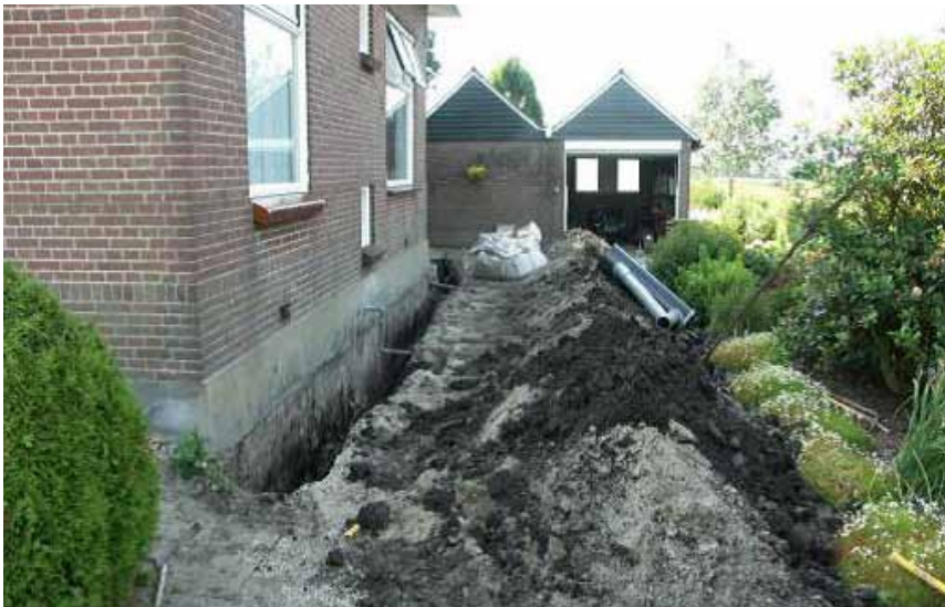
Aanleg infiltratieleiding langs gevel
