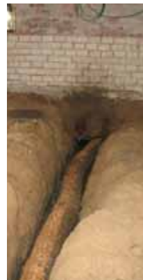
Aanleg infiltratieleiding in kruipruimte Heysterbachstraat te Dordrecht
