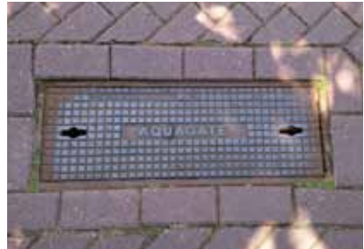
Inspectieput voor de aangelegde infiltratieleiding.
